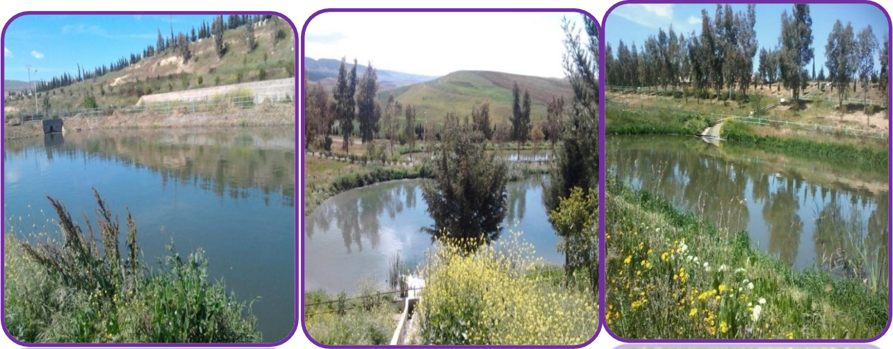
Photos (1, 2,3). Bassins de décantation (à gauche), optionnels (milieu) et de maturation (à droite) Béni-Fouda) (photos prises, 2013)
