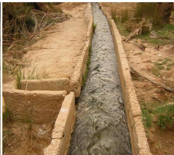
**Figure 3 :** La conduite à ciel ouvert (Foufou 2009). « La conduite est parfois à ciel ouvert. Elle parcourt quelques Kilomètres avant l'arrivée à la palmeraie. Des ouvertures ont été créées en amont de la conduite servant à irriguer les exploitations qui situent à ce niveau, sachant que les ouvertures sont identiques à celles du bassin de distribution qui se positionne en aval de la conduite »
