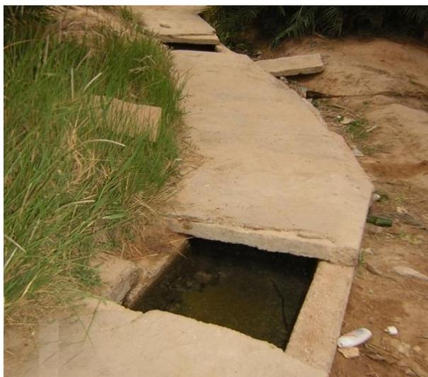
**Figure 2 :** La Conduite enterrée de Chettma (Foufou 2009). « La conduite est couverte par des dalles en béton armé afin de préserver un débit important à la parcelle»
